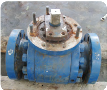
兖矿国泰黑灰水维修
